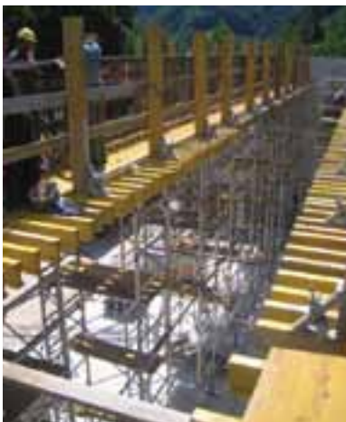
podpiranje armirano betonskega nosilca telovadnice
