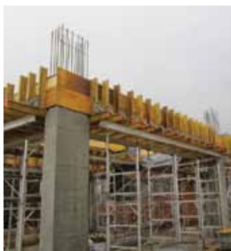
podpiranje armirano betonskih nosilcev
