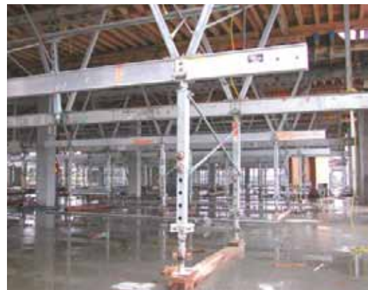
podaljševanje noga v položaju za betoniranje
