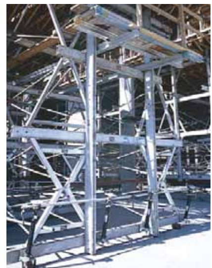
ogrođje iz A-okvirjev v štirih vrstah
