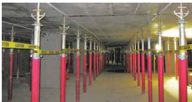
Mega podporniki z vpadnimi glavami po razopazanju ostanejo na mestu, panele in nosilce Modudeck pa uporabimo pri naslednji fazi betoniranja.
