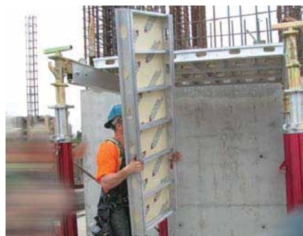
Paneli Modudeck so lahki in trpežni.
