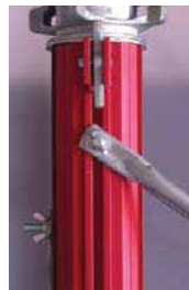
detajl stika mega podpornika in križne opore
