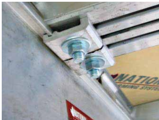
Panele Modudeck pritrdimo na nosilce z NFS spojko.
