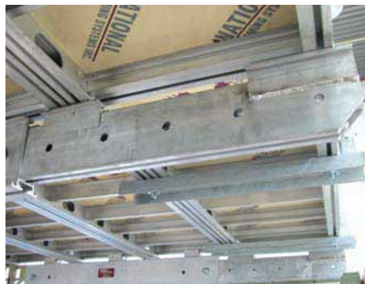
Nosilci Modudeck imajo možnost pritrditve podaljškov za podporo panelov oziroma plošče.
