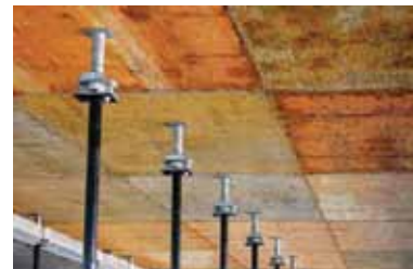
podpiranje plošče po odstranitvi nosilcev Titan
