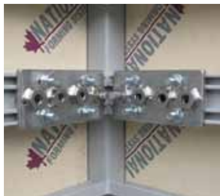
notranji kotnik s pritrjeno univerzalno vezno ploščo
