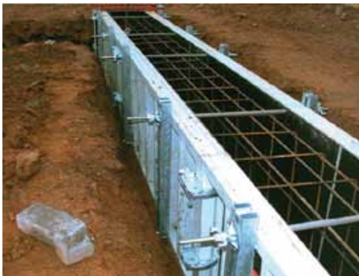
detajl stika med perforiranim trakom in spono temelja
