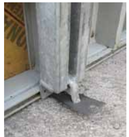
detajl stika med perforiranim trakom in spono temelja
