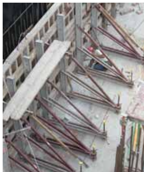
opaž pripravljen za betoniranje
