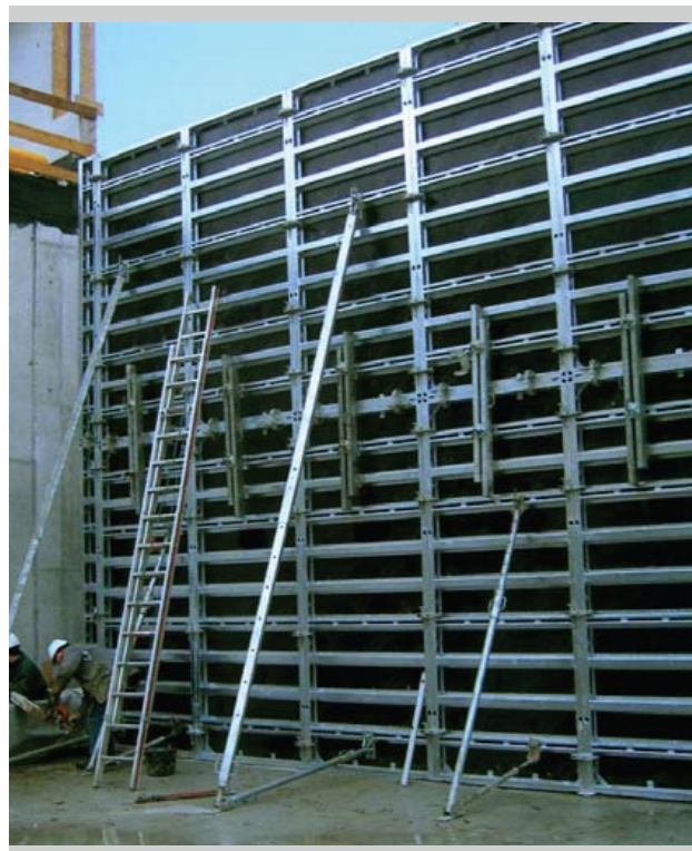
▲ za vertikalno poravnavo dveh panelov uporabimo spojni profil in spojke RS-T
