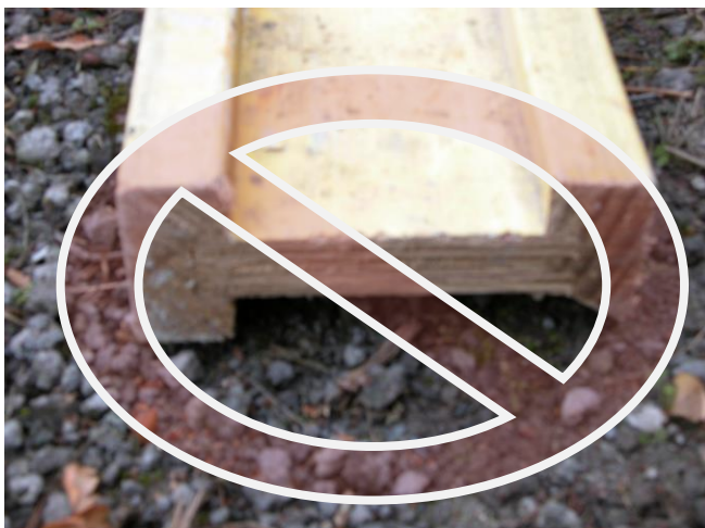
Slika 5: Primer prežaganega lesenega nosilca
