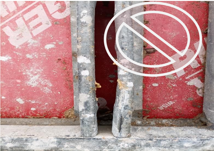
Slika 30: Primer izkrivljeni profili
