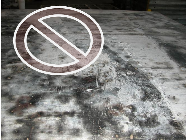
Slika 21: Primer ostanka betona na panelu
