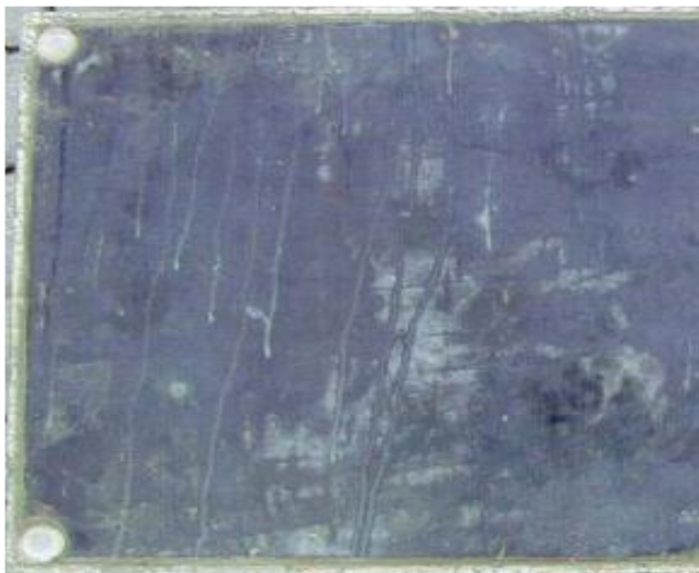
Slika 22: Primer ostanka betonskega mleka na panelu
