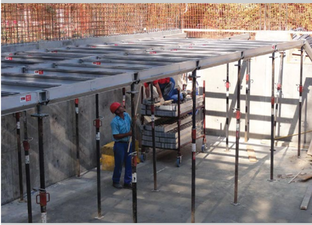
▼ del postavljenega sistema HV NATIONAL za podpiranje plošče
