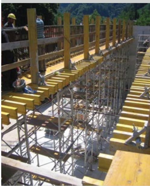
▼ podpiranje armirano betonskega nosilca telovadnice
