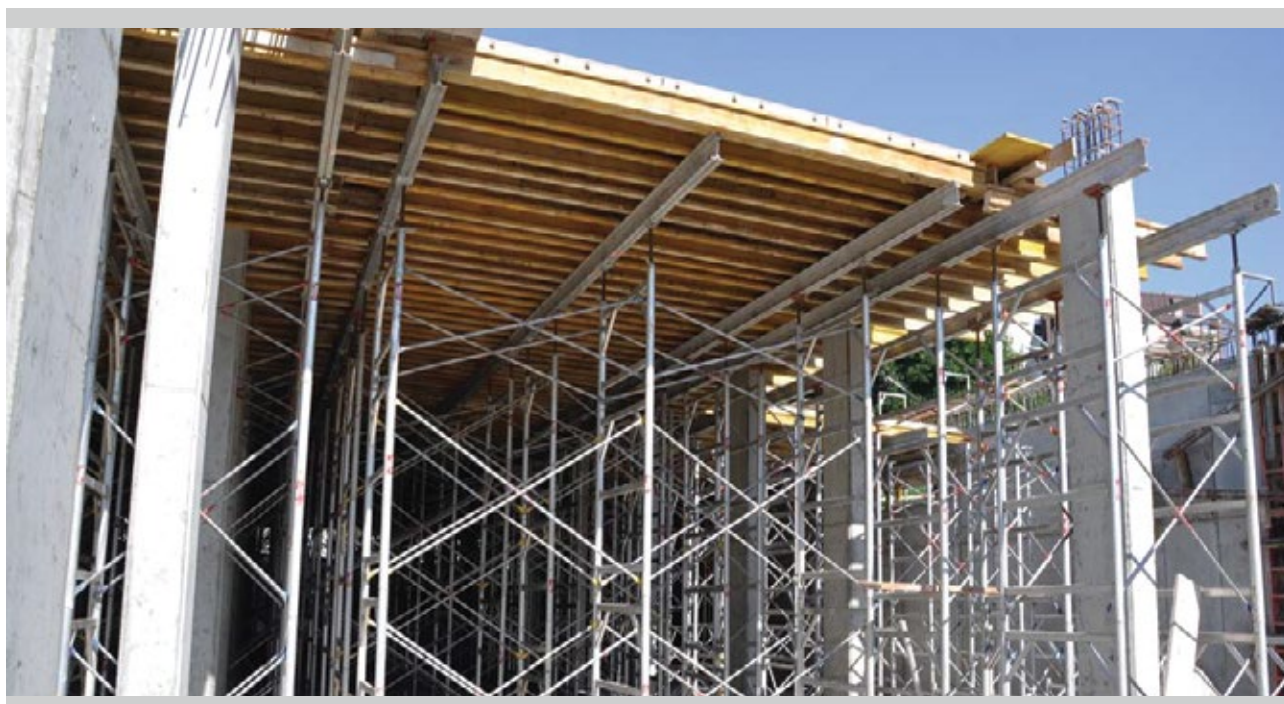
▲ pritrditve sekundarnega nosilca H-20 na primarni ALU-nosilec
