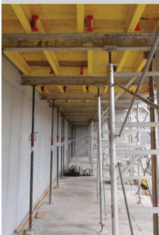
▲ uporabe sistema ALU stolpov v stanovanjski gradnji
