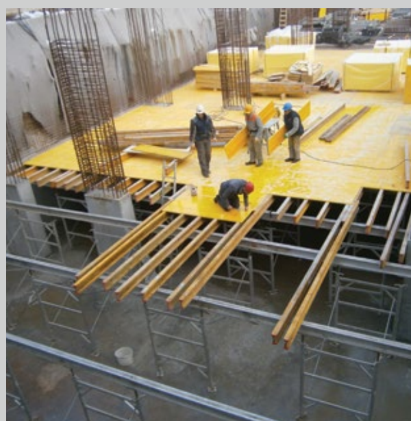
▼ podpiranje plošče garažne hiše
