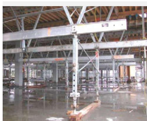
▲ podaljševalna noga v položaju za betoniranje
