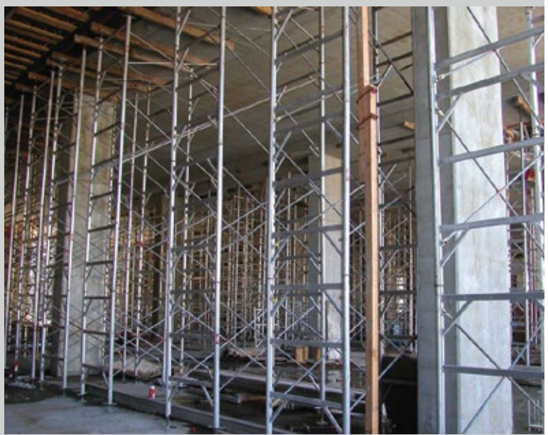
▼ Podupiranje ploče tržnoga centra
