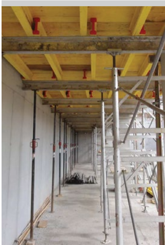
▲ Upotreba sustava ALU-tornjeva u stambenoj izgradnji
