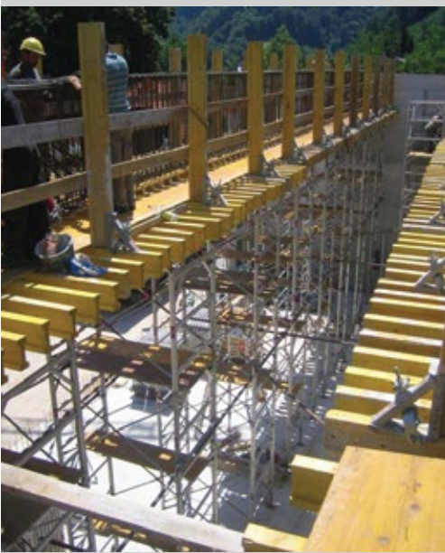
▼ Podupiranje armiranobetonskog nosača hale
