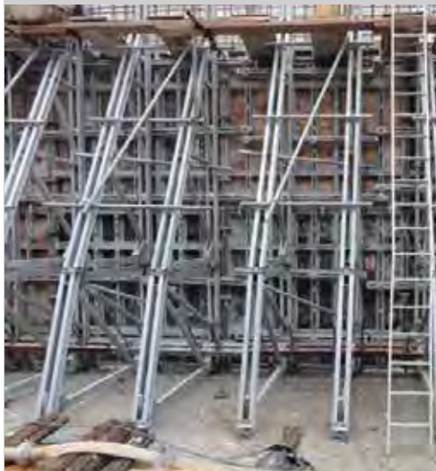
▼ Oplata kružnih zidova
