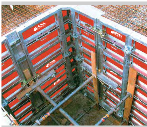
▲ Sastav unutarnjeg kuta uz pomoć zidnih oplata STERLING
