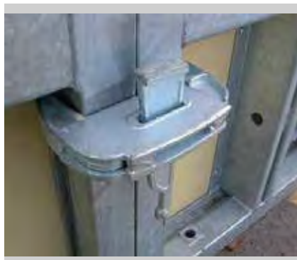
▲ Panele STERLING povežemo veznom spojnicom
