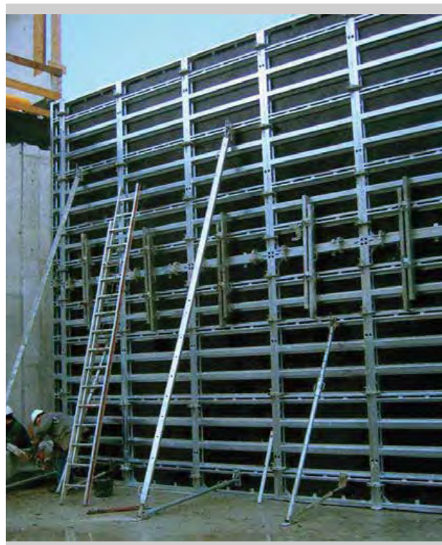
▲ Za vertikalno poravnanje dva profila koristimo spojni profil i RS-T spojnice
