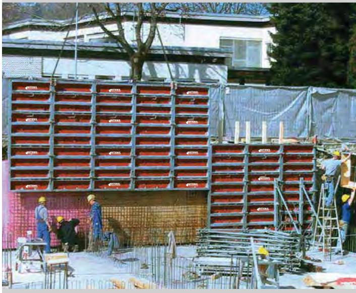
▼ Oplata ravnih zidova
